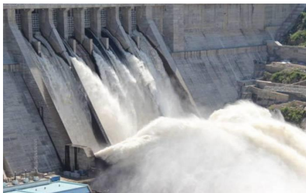
Şəkil 4. Su elektrik stansiyası
